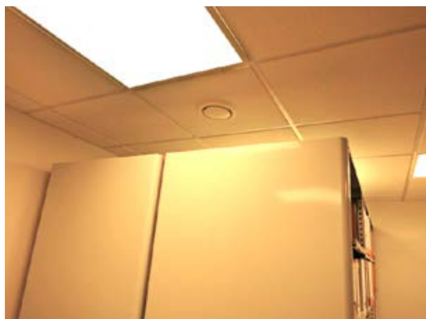
Mynd 7 Á myndinni sést loftinntak sem getur verið nytsamlegt til að viðhalda réttu hita- og rakastigi
